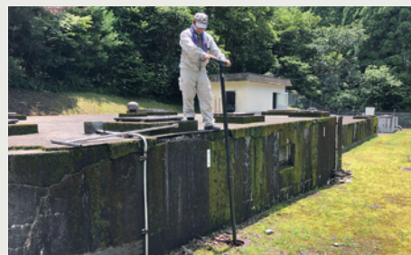
中山間地域の水道施設
