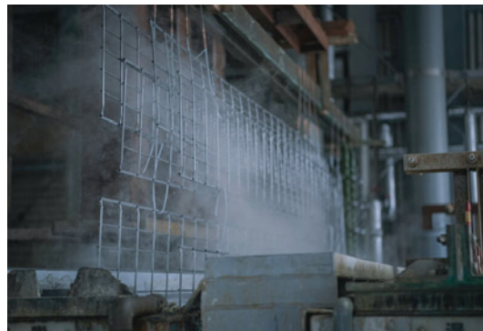
電気めっき・塗装ラインの現場
