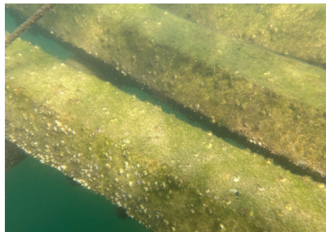
海中に投入した直後の魚礁ブロック。 1年後には岩牡蠣が自然定着した
