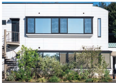
生態系を拡張するランドスケープデザイン 「Re-Wilding HUB」（写真手前の植生）
