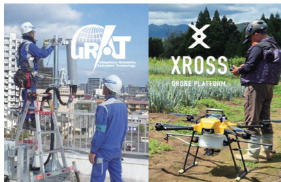
電気通信工事の様子とドローンによる害虫防除の様子
