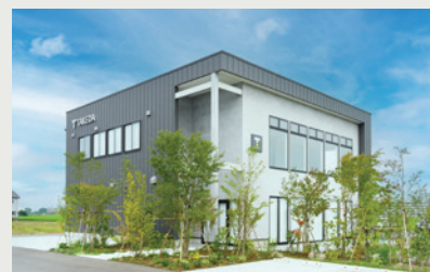
2023年に竣工した新社屋「HEAD SQUARE」
